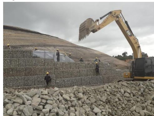
Pemasangan Terramesh di Kariangau, Kalimantan Timur, Indonesia (2019)
