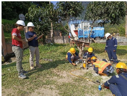
Pengetesan Grout di Maninjau, Sumatera Barat, Indonesia (2024)
