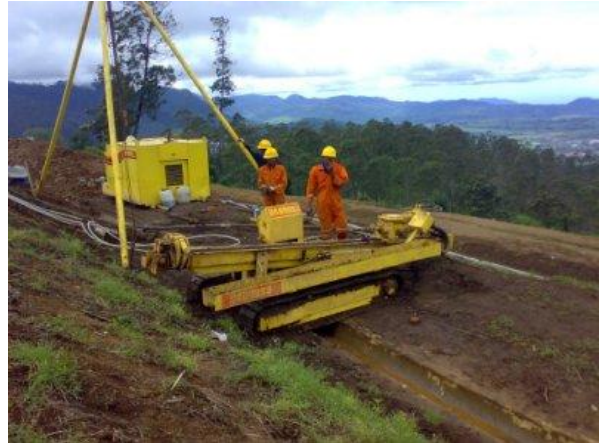
Pemasangan Horizontal Drain di Pangalengan, Jawa Barat, Indonesia (2008)
