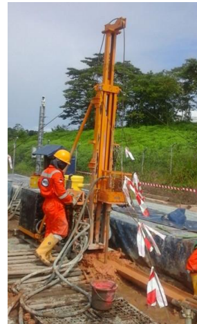
Pemasangan micropile di Tangguh, Papua, Indonesia (2013)
