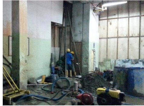
Pemasangan micropile di ruang terbatas Ancol, Jakarta, Indonesia (2013)
