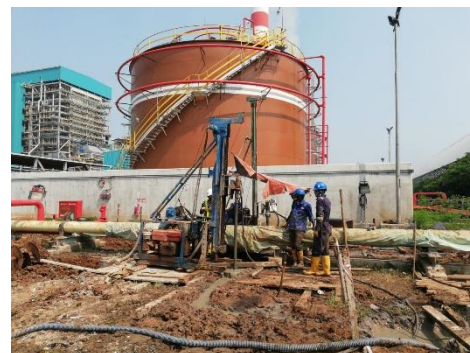
Pemasangan Mini Bore Pile di PLTU Lontar, Tangerang (2021)
