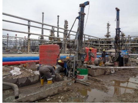
Pemasangan Mini Bore Pile di RDMP Balikpapan (2022-2023)
