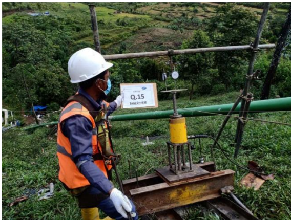
Pengujian Uji Tarik Nail di Lereng
