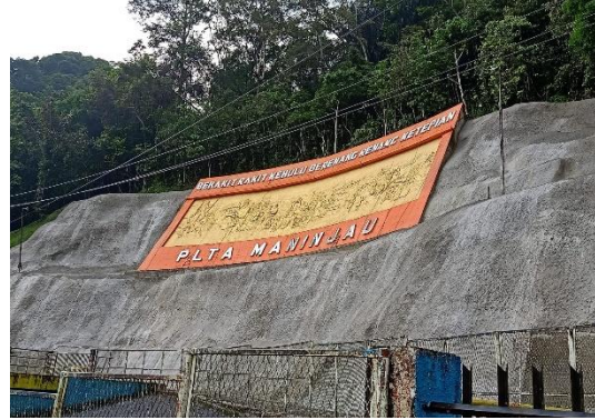
Pekerjaan shotcrete di PLTA Maninjau, Sumatera Barat, Indonesia (2024)
