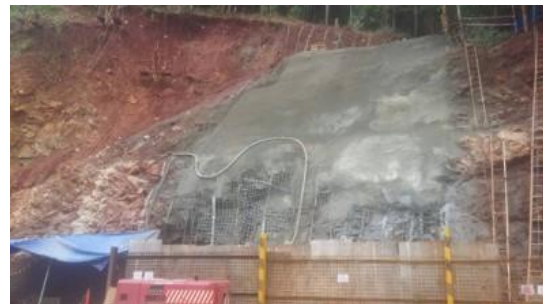
Pekerjaan shotcrete di Sorowako, Sulawesi Selatan, Indonesia (2014)
