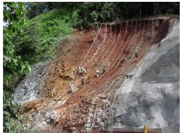
Pemasangan soil nailing dikombinasikan dengan shotcrete di Karebbe KM 38+600 proyek di Sorowako, Sulawesi Selatan, Indonesia (2016)
