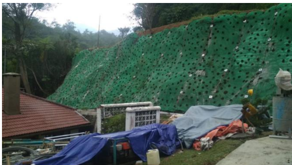
Pemasangan soil nailing dikombinasikan dengan geomat pengendali erosi di Puncak, Jawa Barat, Indonesia (2019)
