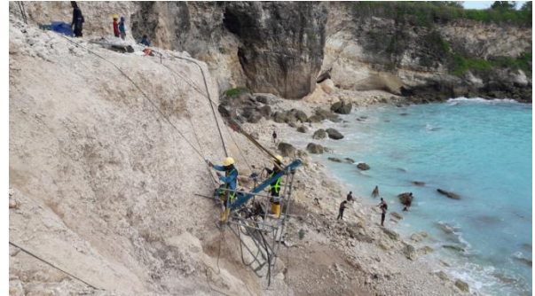
Pemasangan soil nailing di lereng pantai di Nusa Ceningan, Bali, Indonesia (2017)
