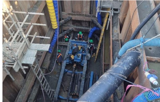
Pemasangan pipa minyak di Balongan, Jawa Barat, Indonesia, 2025
