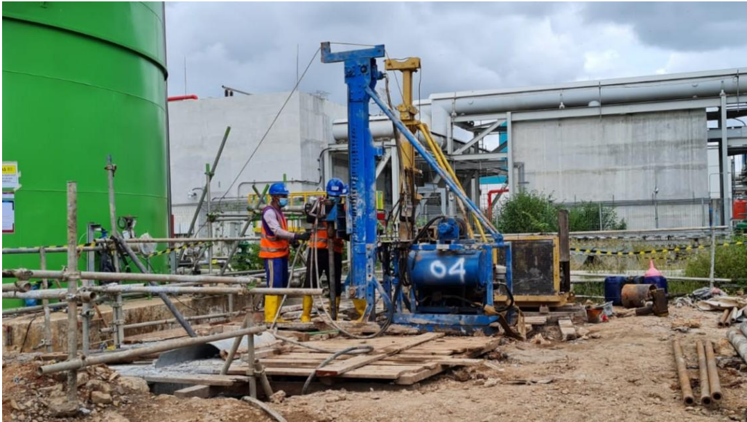
Peralatan Mini Bore Pile dan Micropile - Tipe Jacro
