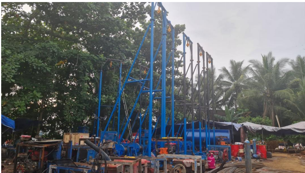
Peralatan Mini Bore Pile dan Micropile - Tipe Gawangan
